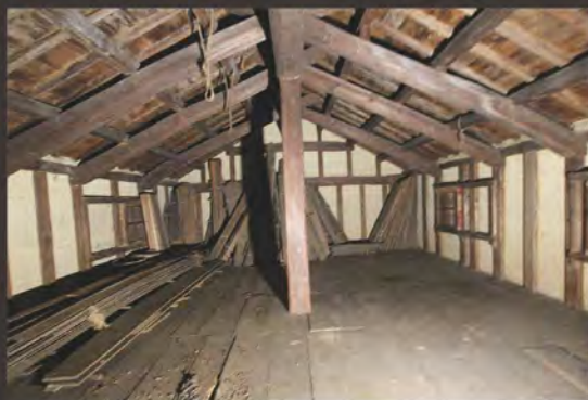
MUNE棟 (村上邸土蔵) 改修前
