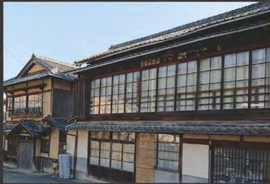
SADA棟 (浦岡邸) 外観 改修前
