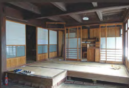
OKI棟 (村上邸) 内観 改修前
