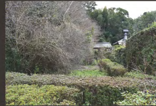
MUNE棟 (村上邸中庭) 改修前
