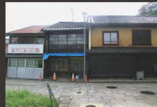
OKI棟 (村上邸) 外観 改修前
