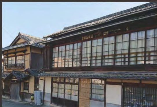
SADA棟(浦岡邸)外觀 改修前
