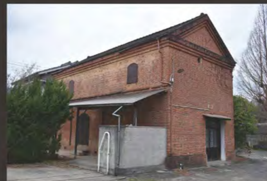
臥龍釀造(旧井関邸煉瓦蔵)外觀 改修前
