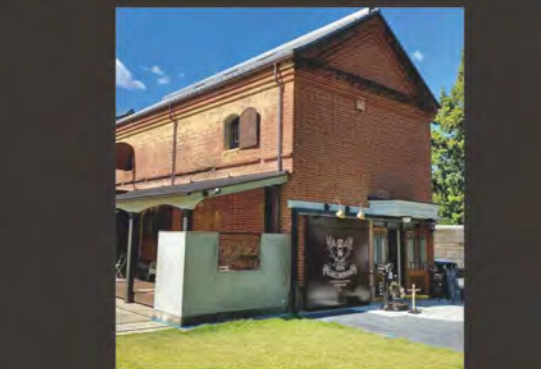
臥龍釀造(旧井関邸煉瓦蔵)外觀 改修後 2021年9月OPEN
