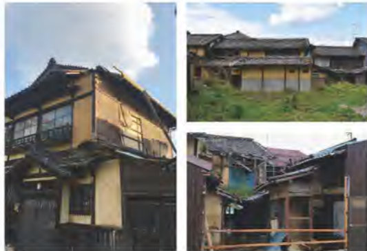
改建前的建築物狀況
