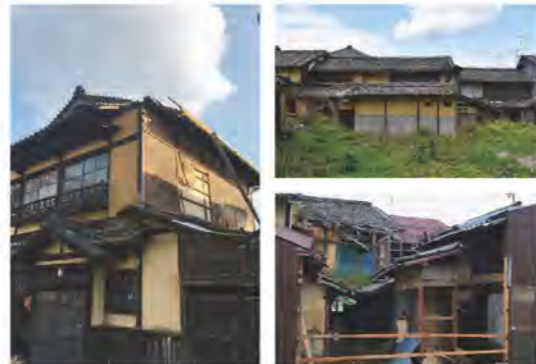
改建前的建築物狀況
