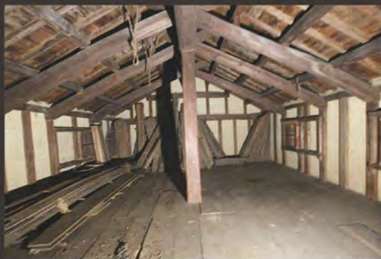
MUNE棟(村上邸土蔵) 改修前
