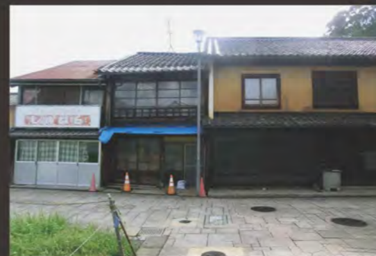
OKI棟(村上邸)外觀 改修前
