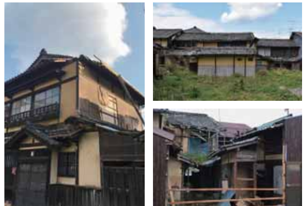
改修前の建物の状況
