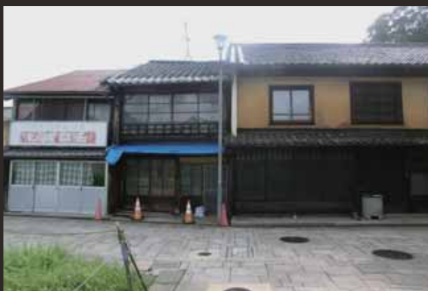
OKI棟(村上邸)外観 改修前
