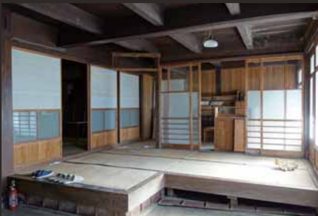
OKI棟(村上邸)内観 改修前
