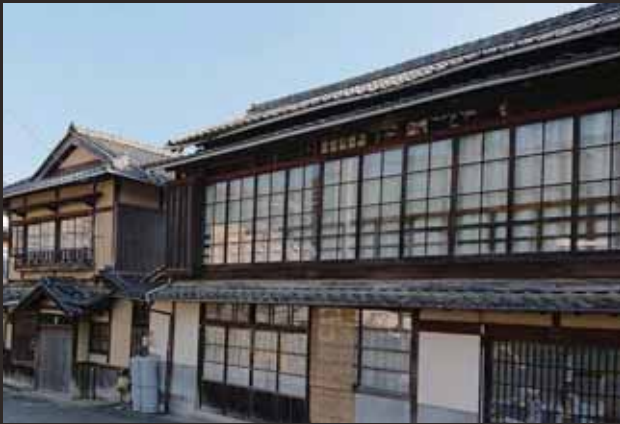
SADA棟(浦岡邸)外観 改修前
