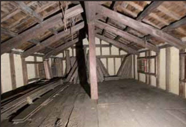
MUNE棟(村上邸土蔵) 改修前
